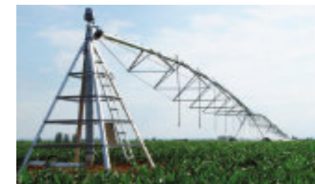
Torre centrale e campate
